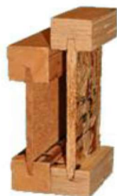
belki dwuteowe – z drewna litego i z twardej płyty pilśniowej oraz z LVL i płyty OSB fot. Ewa I. Kotwica
