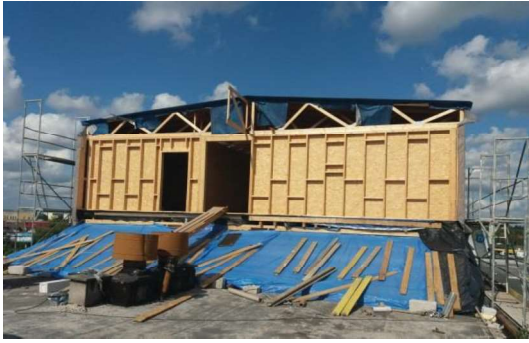
Nadbudowa budynku wielorodzinnego fot. Włodzimierz Warkoczyński
