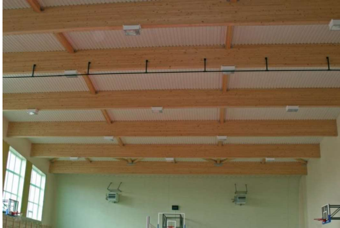
Przekrycie sali sportowej, Polska fot. Ewa I. Kotwica
