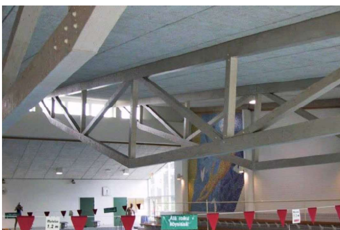
Kratownice z LVL Przekrycie pływalni w Finlandii. Fot. Ewa I. Kotwica
