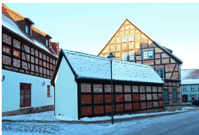
Zabudowa w technologii muru pruskiego Fot. Ewa I. Kotwica
