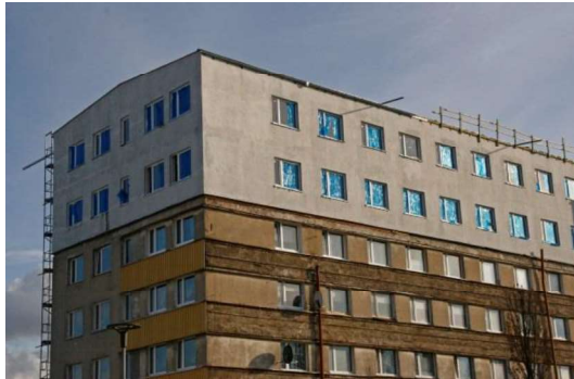
Nadbudowa budynku wielorodzinnego fot. Ewa I. Kotwica
