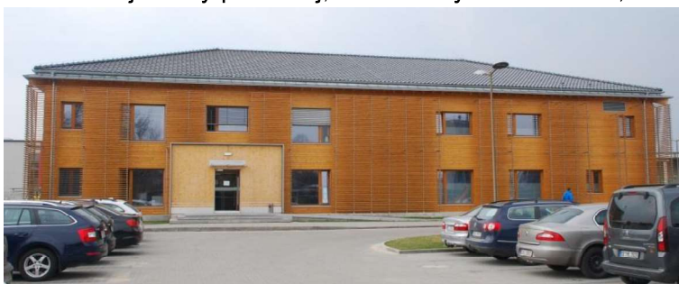
Budynek straży pożarnej w Murowie, fot. Andrzej Noskowiak
